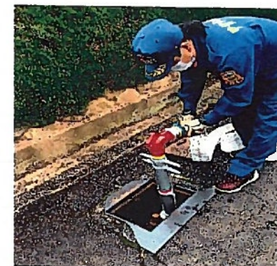
④ホースの受け口を結合する
